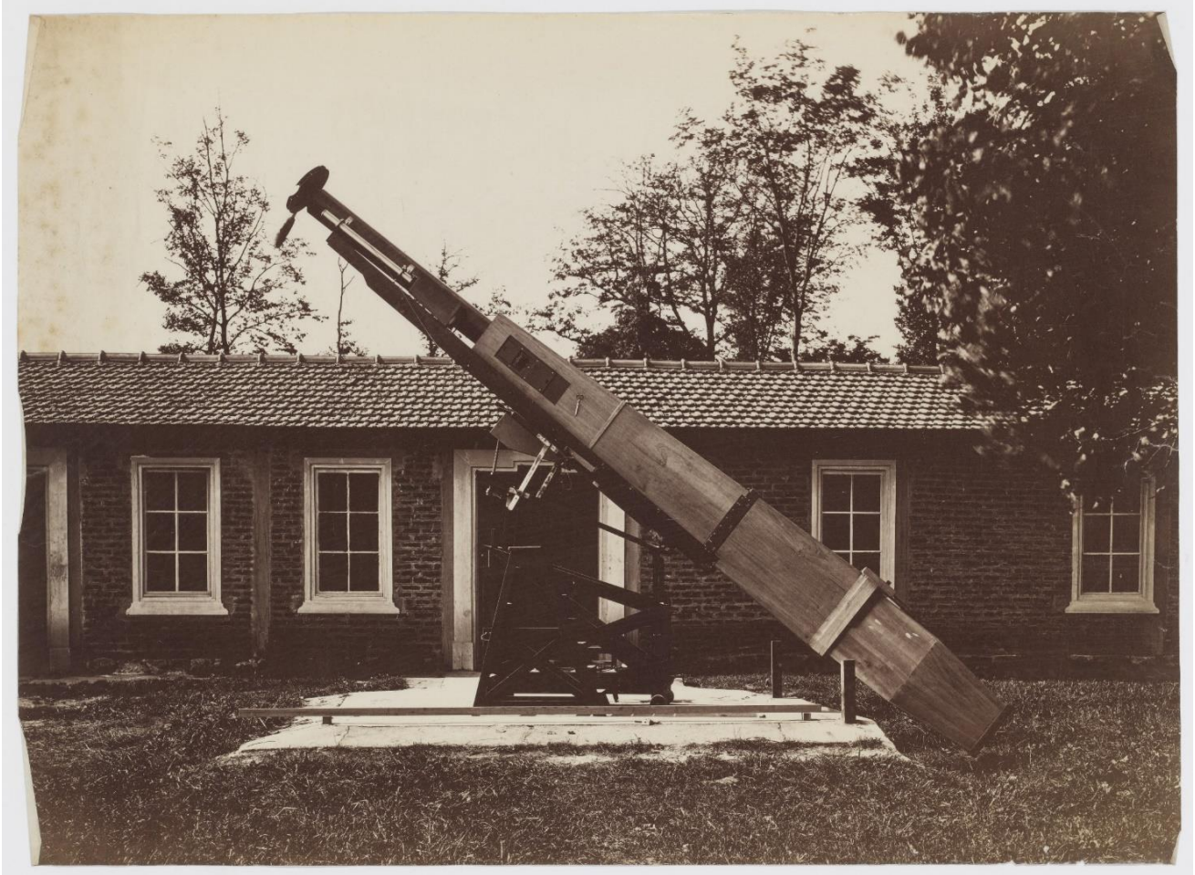
Figure 17 : lunette solaire de Janssen dans le parc de Meudon à la fin du XIX ème siècle. Elle était installée à ses débuts sur une monture roulante en bois. L'objectif avait 14 cm de diamètre pour 2 m de focale, mais un oculaire agrandissait considérablement les images pour utiliser des plaques de 30 x 30 cm 2 au foyer. Crédit OP.
