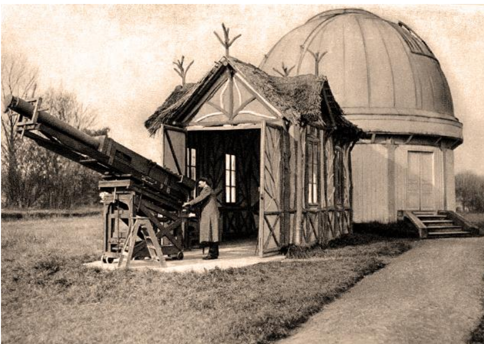
Figure 17 : lunette solaire de Janssen dans le parc de Meudon à la fin du XIX ème siècle. Elle était installée à ses débuts sur une monture roulante en bois. L'objectif avait 14 cm de diamètre pour 2 m de focale, mais un oculaire agrandissait considérablement les images pour utiliser des plaques de 30 x 30 cm 2 au foyer. Crédit OP.
