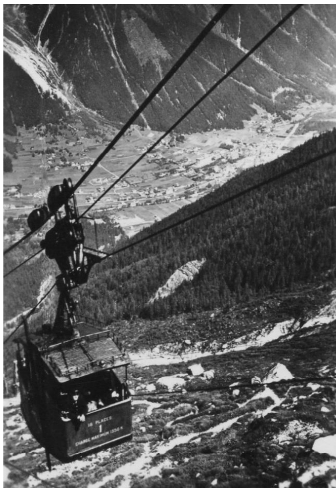
Figure C8 : le téléphérique tri-câble (porteur-frein-tracteur) des Glaciers en deux tronçons montant à 2400 m, avec la vallée de Chamonix dans le fond (collection de l'auteur)
