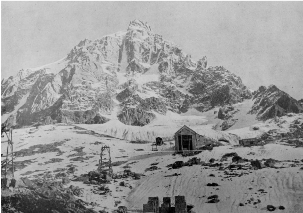
Fig C4 : station des Glaciers 2400 m en construction avec ligne de chantier (collection de l'auteur)
