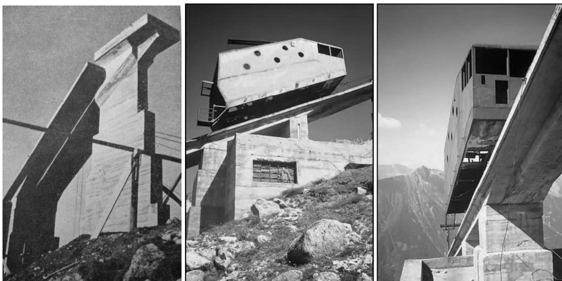
Figure C15 : plan incliné pour la tension des câbles de la ligne des Glaciers (2400 m) au col du Midi (3600 m) par un chariot contre poids (collection de l'auteur)
