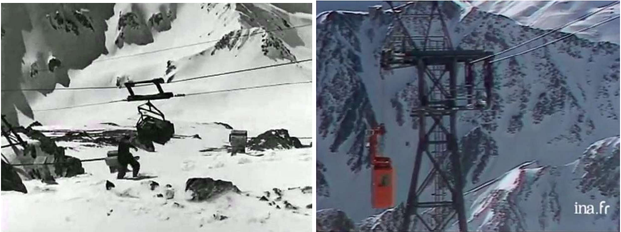
Fig D1 : benne de service (1949) avec laquelle on construisit le téléphérique en 1952 (crédit INA)
